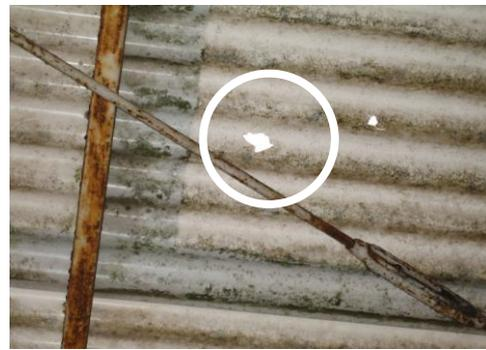
写真右 穴があいたプラスチック製の屋根（小林市）
