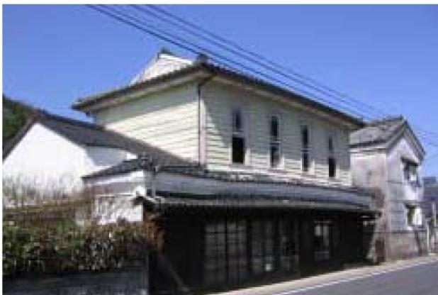
池田家住宅主屋は、明治末に建てられたと伝えられている木造2階建の建物です。明治34年竣工の大隅横川駅舎前を北に延びる街道に東面して店舗兼住宅と石倉が並んで建っています。入母屋造2階建で、1階は梁間桁行とも6.5間で、2階は梁間3間、桁行4.5間の規模です。1階の街路に面した部分は、開放的な引き違い窓で、かつて商店を営んでいたことが伺えます。2階は四方とも下見板張りで、街路に面した東面と北面に設けられた開口部は全て縦約2.5m幅0.9mの上げ下げ窓となっています。2階は八畳間と座敷の2間があります。天井が高く美しい欄間を備え、床の脇には天袋・地袋を伴った棚を持ち、全体として洗練された印象です。右隣には、国登録有形文化財の石倉が建っています。
