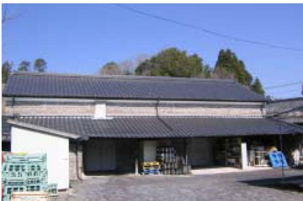
森山家住宅石倉は、大正5年頃建てられた石倉です。床面積約15.3平方メートル、石壁の厚さ約35センチ、外壁の寸法は、梁間約8メートル、桁行約19.8メートルの規模で、軒高約4.5メートル、棟高6.7メートルとなっています。桁行方向の壁は隣地境界の石垣に連続し、全面道路まで伸びています。小屋組と内側の柱・梁・桁等は主に松材で、天井板を張らず屋根は板張りの上に平木を載せた瓦葺きです。倉庫南面に、高さ約230センチのアーチ型の出入口が2カ所あり、観音開きの鉄扉がついています。
