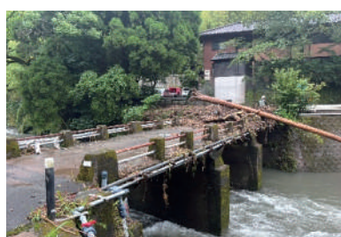
令和7年8月の妙見崎橋の様子
