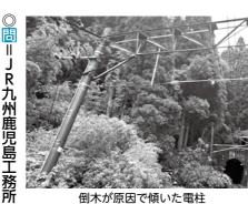
倒木が原因で傾いた電柱
