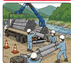
仮設配管の資材が到着。工事開始
