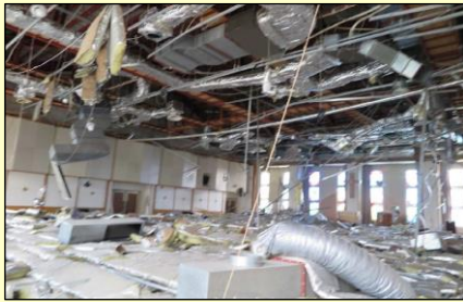
(最上階ホール天井の脱落)
